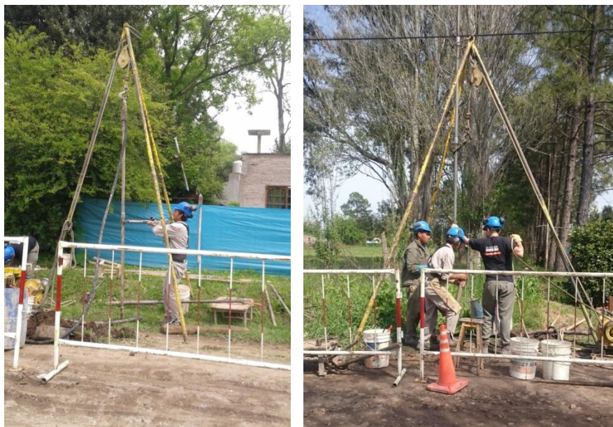
Ilustración II-10: Perforaciones Geotécnicas Pn1 y Pn2
